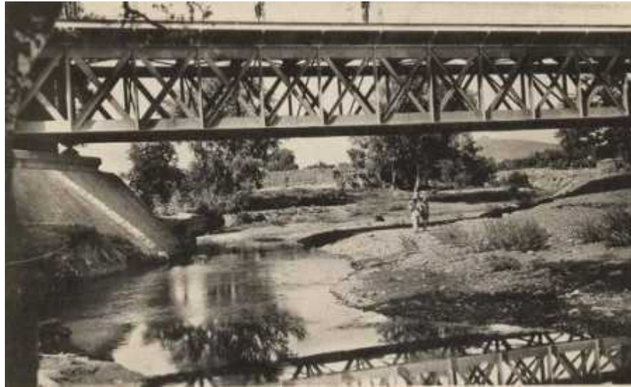
Le pont de la gare
